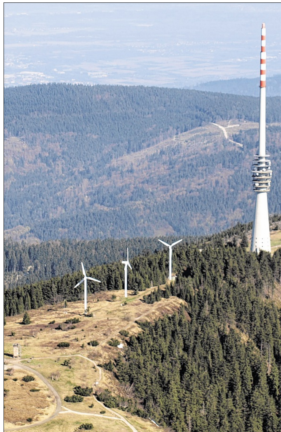
DREI WINDRÄDER gibt es zur Zeit auf der Hornisgrinde. Eine einzige, weit größere Anlage soll sie ersetzen. Investor Griebel will bald einen Bauantrag stellen. Foto: ug/Archiv
